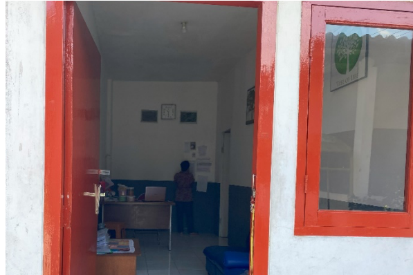
Gambar 10. Dokumentasi bukaan pada ruang perawat
