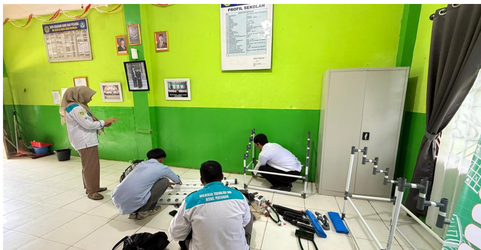
Gambar 3. Kegiatan pemasangan Instalasi Akuaponik di SMA Islam Al-Amalul Khair
