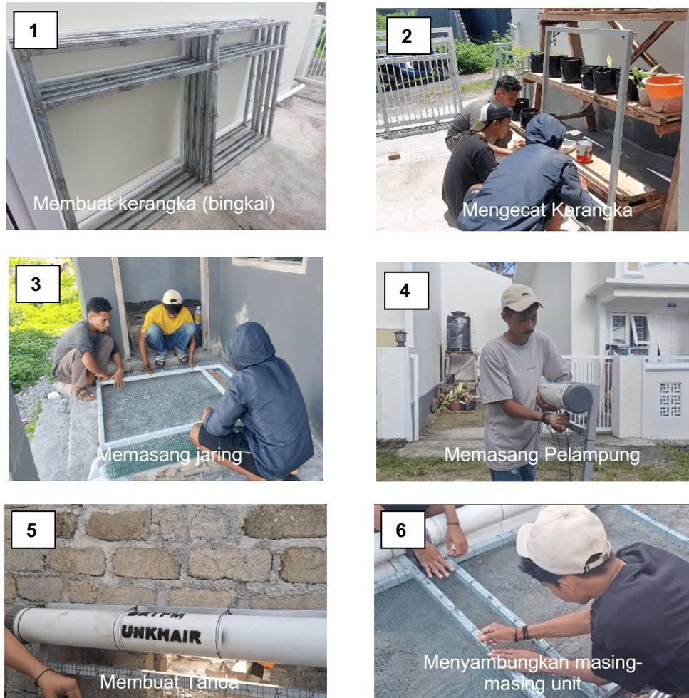
**Gambar 6.** Tahapan Pembuatan Alat Perangkap Sampah (*Waste Trap*)
