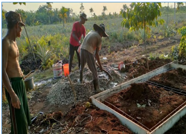
Gambar 2. Proses Pembuatan Bak Kompos
