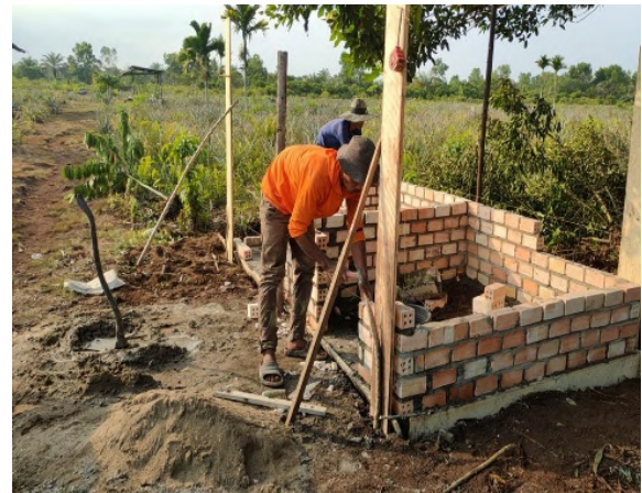
Gambar 2. Proses Pembuatan Bak Kompos
