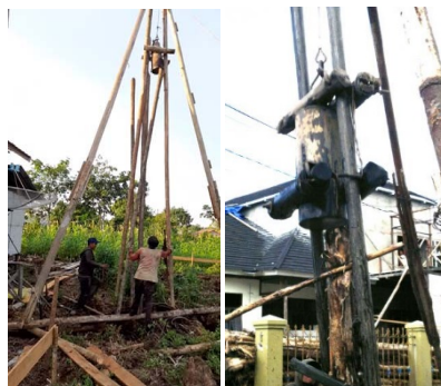
Gambar 21. Pancangan Galam Dengan Mesin
