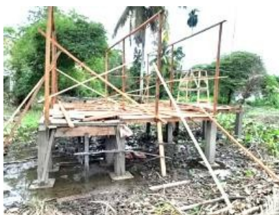
Gambar 8. Penggunaan Pondasi Plat Beton (Sumber : Nurfansyah, 2020)
