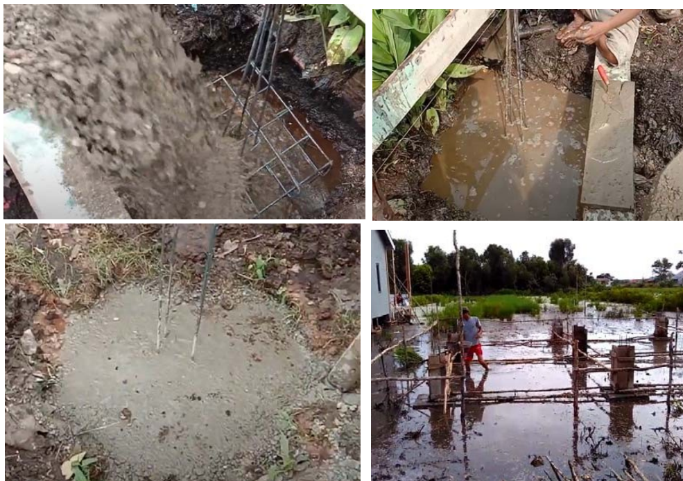
Gambar 25. Proses Pengecoran Dalam Air
