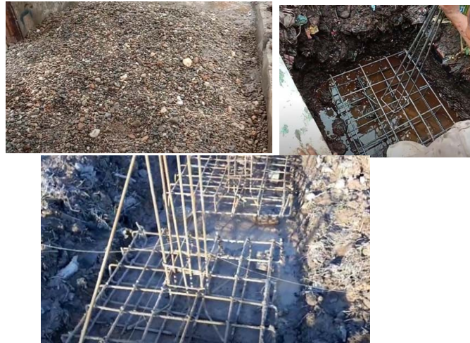
Gambar 24. Adukan Semen dan Kerangka Pondasi
