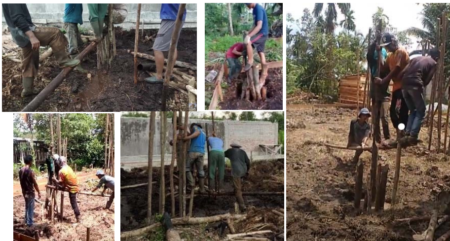
Gambar 19. Pancangan Galam Secara Manual
