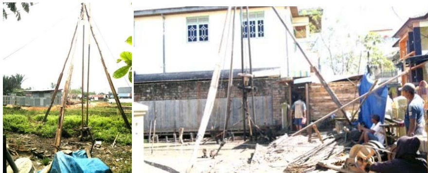
Gambar 20. Pancang Galam Dengan Mesin
