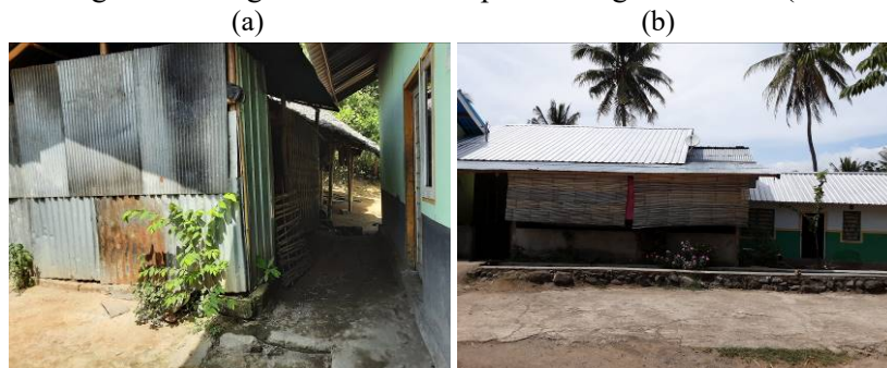
Gambar 10. (a) Huntap KK2 dengan penambahan dapur di seberang rumah, dan (b) Huntap KK3 dengan penambahan dapur di sebelah kiri rumah (Sumber: kunjungan lapangan, Januari 2023)
