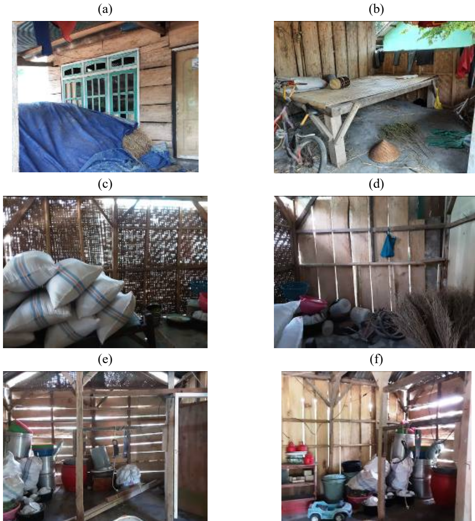
Gambar 8. Kondisi terakhir huntara pada (a) teras sisi kanan bangunan, (b) teras sisi kiri bangunan, (c) gudang khusus hasil panen, (d) gudang khusus perkakas, (e) gudang besar sisi depan, (f) gudang besar sisi belakang (Sumber: kunjungan lapangan, Januari 2023)
