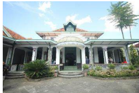
Gambar 5. Fasad Bangunan (Sumber : Penulis, 2024)
