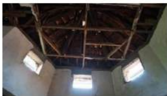
Gambar 86Kondisi awal bagian plafond di gandhok tengen mburi
