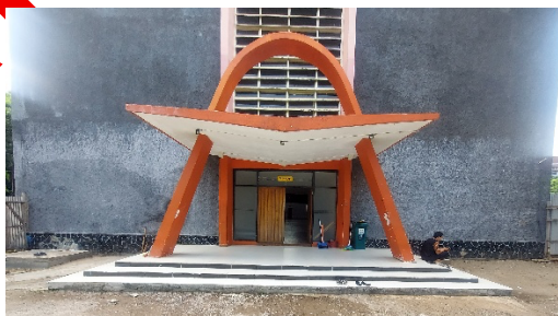
Gambar 3. 5 Kolom Mirip Huruf “V” dan Kanopi Nonkonvensional di Sisi Selatan GOR Saparua yang Menjadi Ciri Gaya Jengki
