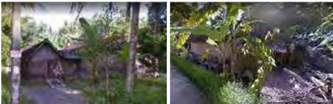
Gambar 3. Kondisi Rumah Tidak Sehat di Desa Murtigading Sumber: Penulis
