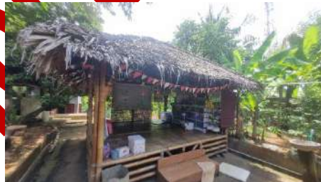
Gambar 5. Ruang Kelas TK A dan TK B
